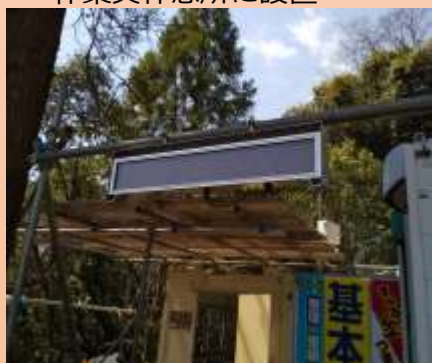
作業員休憩所に設置
