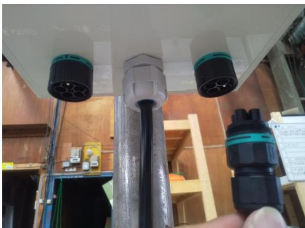
差し込み後、開閉コネクタを閉め抜けを確認します。
